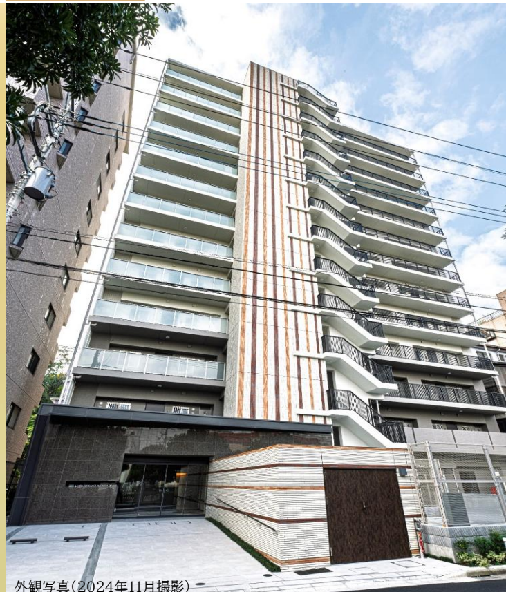
外観写真(2024年11月撮影)
